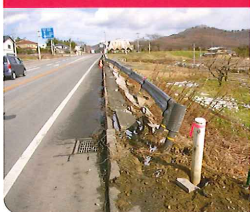
ガードレール・標識等の損傷
